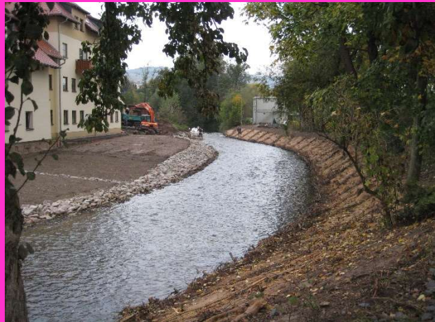
Beispiel: Zöllnitz, Wehrrückbau an der Obermühle in der Roda
